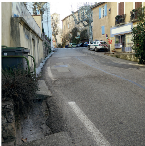
La route de Salernes en février, juste avant les travaux
